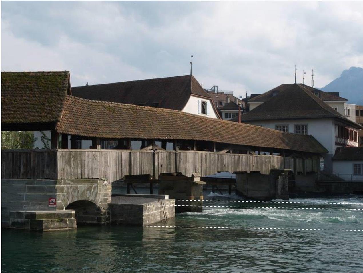
Abb.: Das auf gemauerten Flusspfeilern ruhende Tragwerk, die markante Dachabdeckung und der vertikale Bretterschirm der Spreuerbrücke. Sichtbar ist auch die Treninsel, die unterhalb der Reuss im Zusammenhang mit dem Abbruch der „Wasch- und Badeanstalt“ ebenfalls entfernt wurde.
