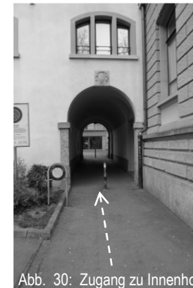
Abb. 30: Zugang zu Innenhof
