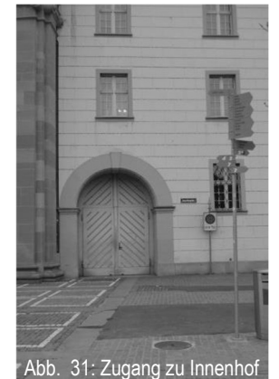
Abb. 31: Zugang zu Innenhof
