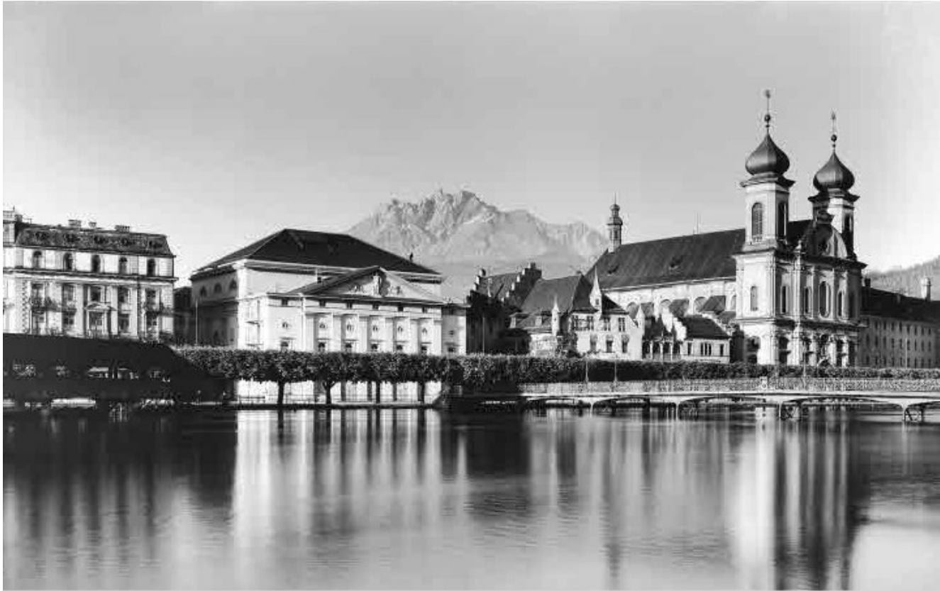
Abb. 4: Freienhof und Jesuitenkirche
