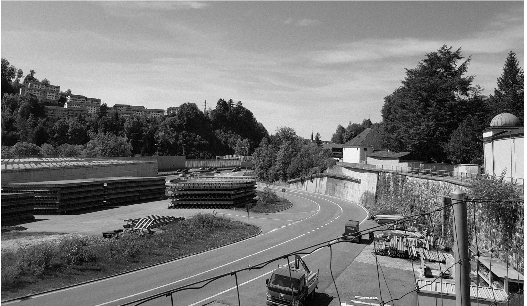
Teilansicht Nordost A2-Anschluss Lochhof
