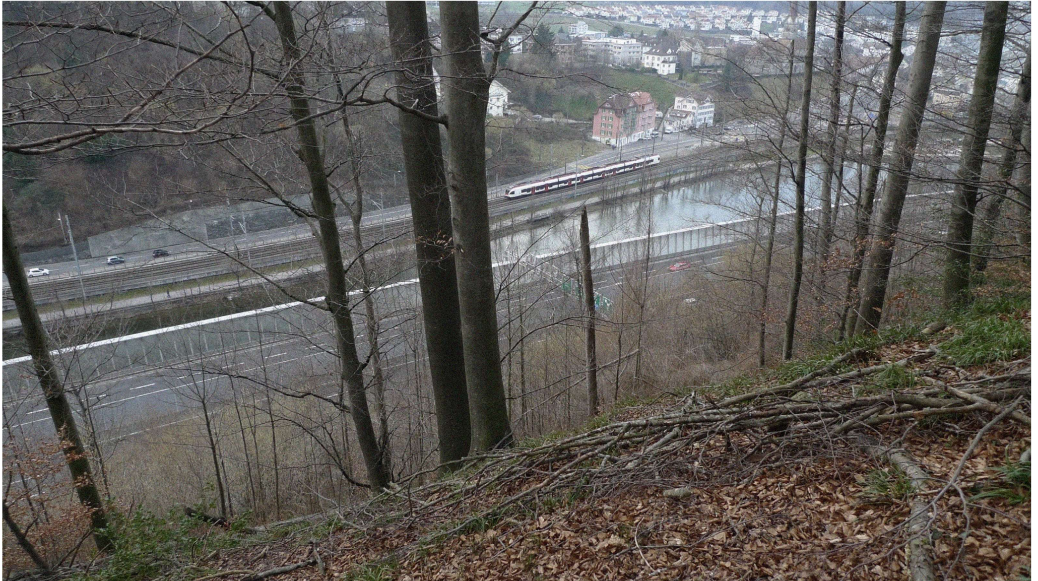
Nordwestlich des Friedentales endet der Greterwald in den Steilböschungen des Reusstales. Das Flussbett der Reuss wird bedrängt durch Bahngeleise, Kantonsstrasse, Fussgänger- und Velowege und sieben Fahrspuren der Auto-Bahn A2. Massive Stützmauern verstärken den Verkehrslärm.
